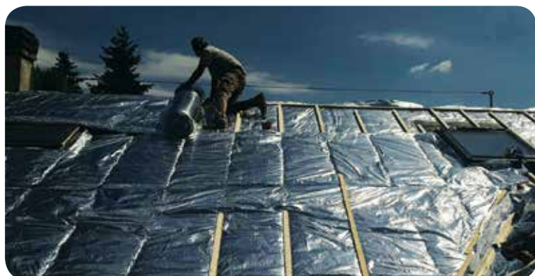
● Posa secondo strato isolante
