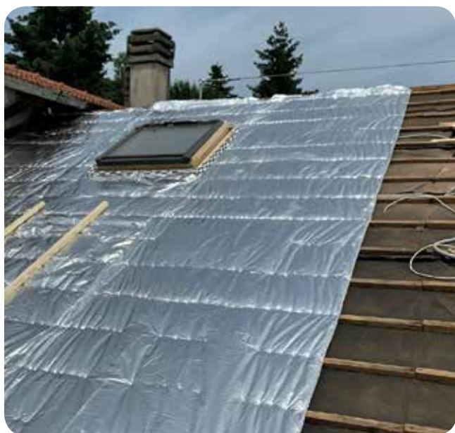
● Posa del primo strato di Over-foil Multistrato 19 su listello porta tegola esistente
