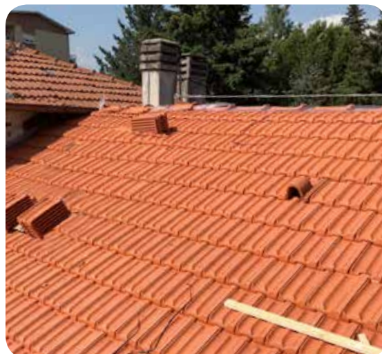
● Posa nuovo manto di copertura
