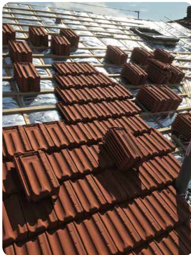
● Posa nuovo manto di copertura
